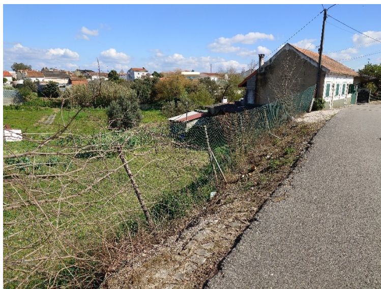
Rua do Vale Tornado degradada, com abatimentos
